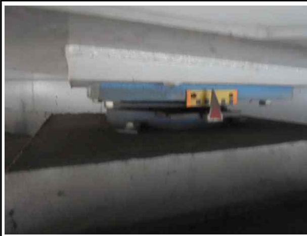
상태양호 (A2 Sh4)
