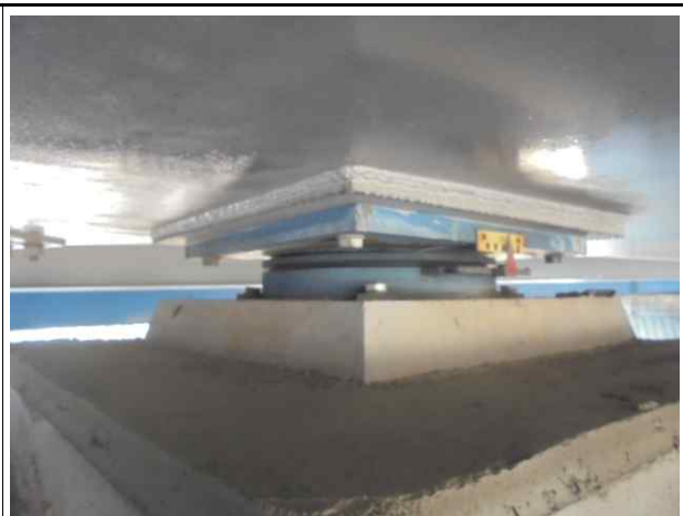
상태양호 (P1 Sh6)
