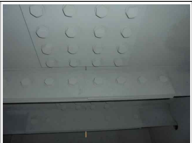
거더 내부 볼트 상태양호
