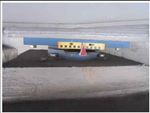
상태양호 (A1 Sh5)
