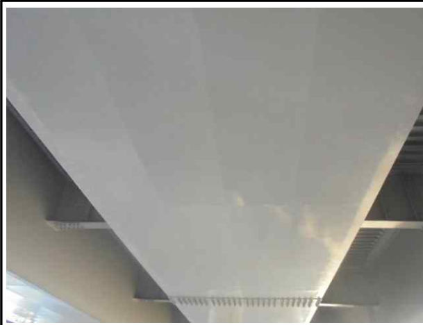
거더 외부 상태양호
