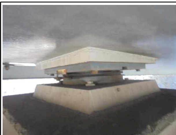
상태양호 (P2 Sh3)
