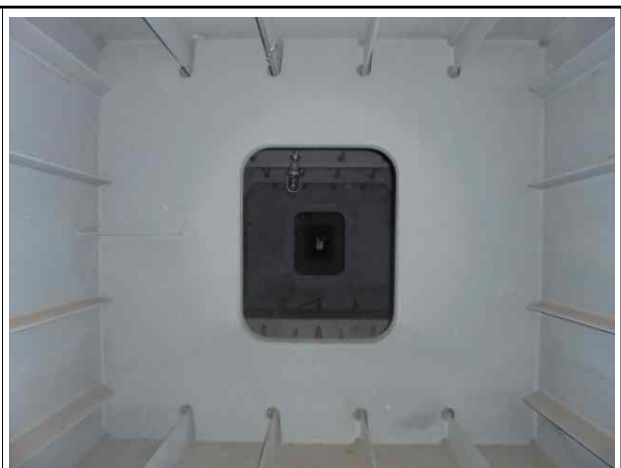
거더 내부 상태양호
