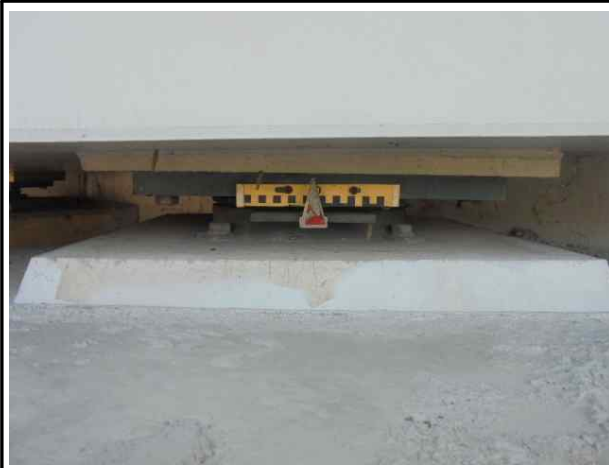
상태양호 (A1 Sh1)
