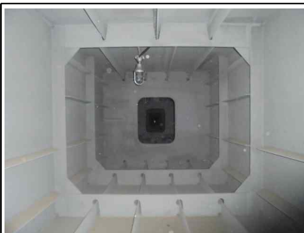
거더 내부 상태양호
