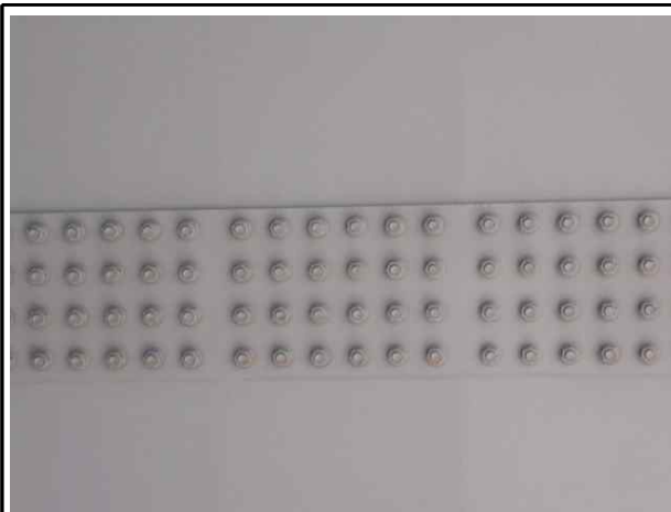
거더 볼트체결 상태양호
