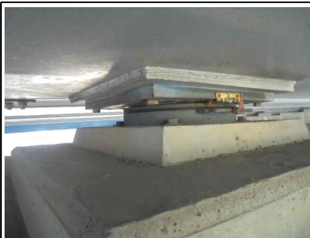
상태양호 (P1 Sh2)
