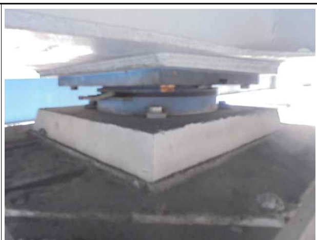
상태양호 (P2 Sh7)
