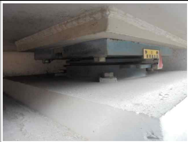
상태양호 (A2 Sh8)
